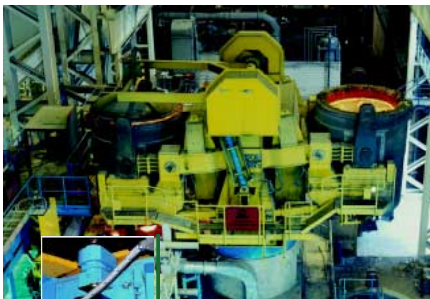
Längenmessung und gleichmäßiger Lauf: In dieser Stranggußanlage liefern Absolut-Multiturn-Tachos AMG 10 und wassergekühlte Digital-Tachos POG 10 die Signale für die Durchlaufgeschwindigkeit und die Produktionslängen.
