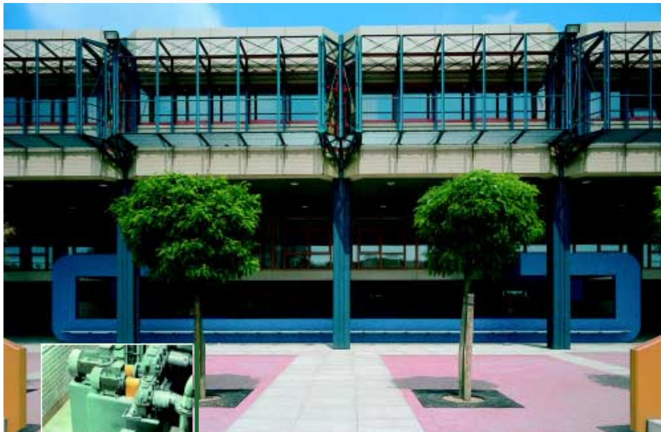
Einsparung von Energie: Wartungsarm und mit hohem Wirkungsgrad erzeugt ein System von 150 Wärmepumpen das optimale »Lernklima« einer Schule. In die Drehzahl-Regelung der Asynchronmotoren sind Digital-Tachos POG 9 von HÜBNER eingebunden.
