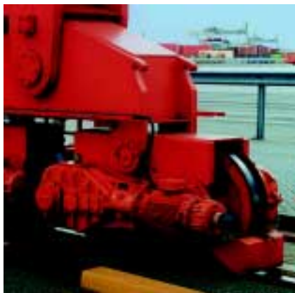
Hart im Nehmen: HÜBNER Digital-Tachos POG 10 erfassen die Drehzahl aller Antriebe im Maschinenraum und an den Fahrwerken dieser Container-Krananlage – bei jedem Wetter, Tag für Tag.
